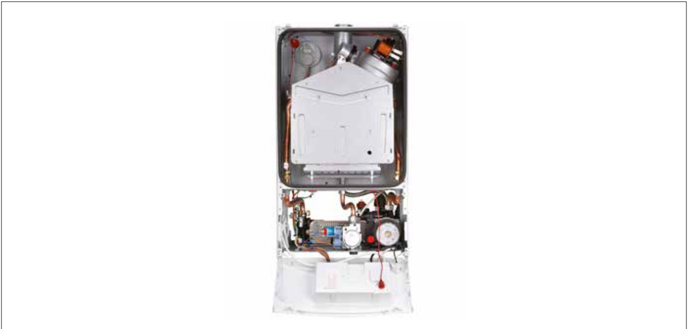
1/2 Техническое оснащение котла Logamax U072
