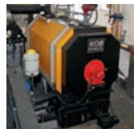
Около 2000 м 2 отапливается котлом Pyrot мощностью 300кВт
